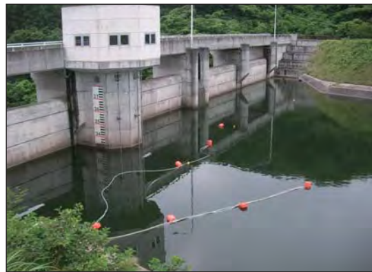
図1 惣の関ダム貯水池での現場実験風景1
